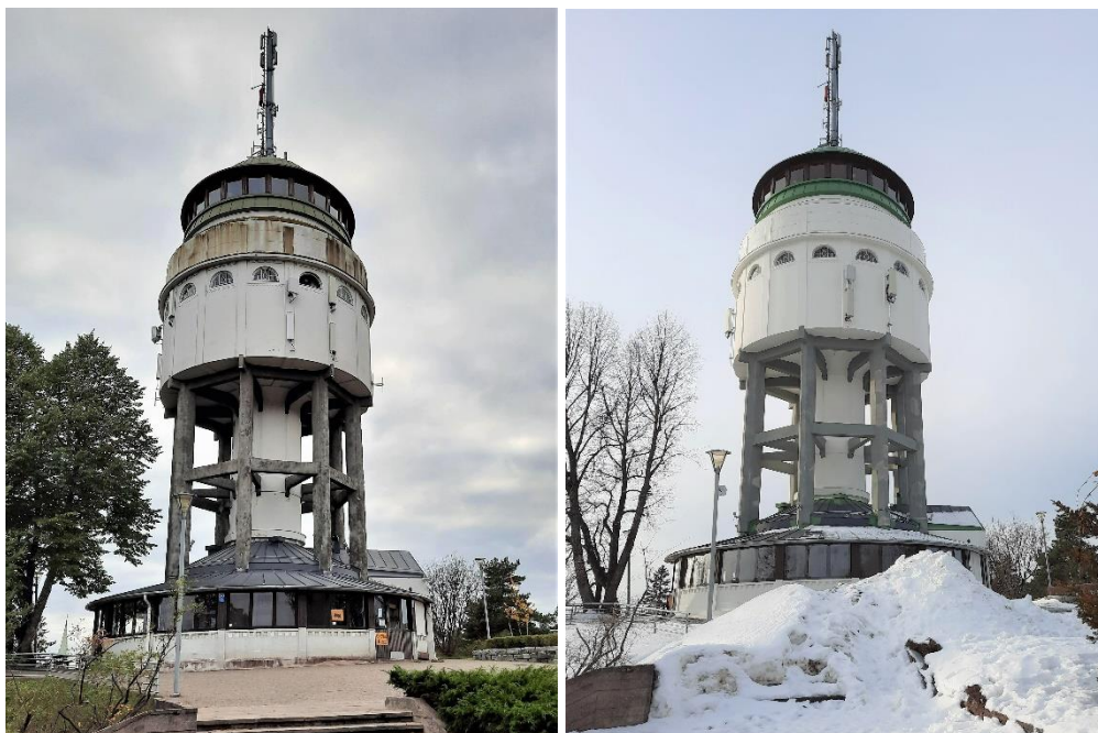
Valokuvat Naisvuoren näkötorresta ennen ja jälkeen kunnostuksen
